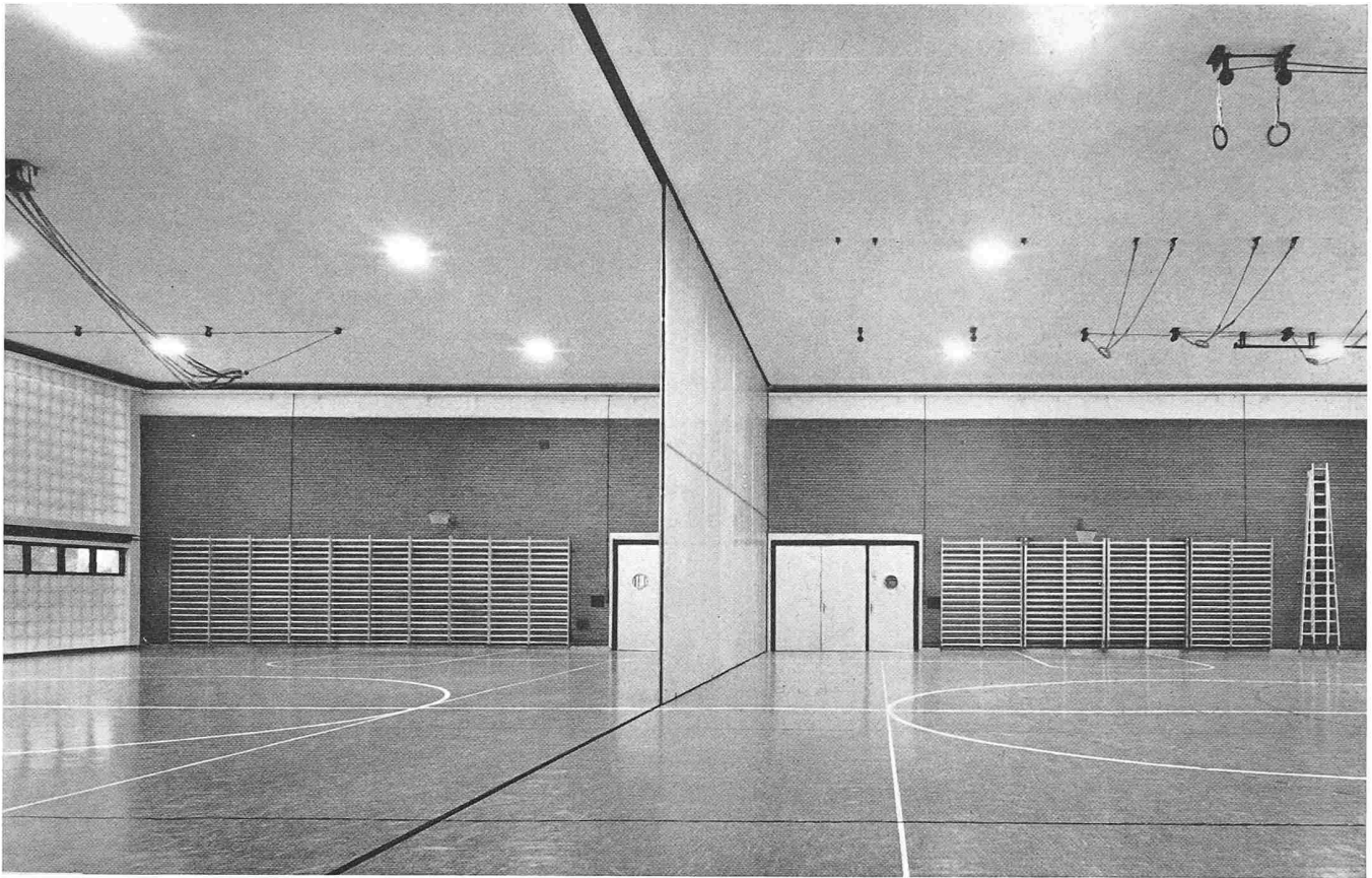
Die Doppelturnhalle mit halb geschlossener Trennwand
