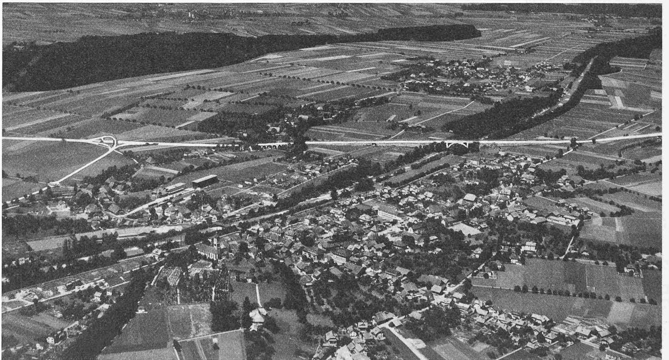
Bild 4. Swissair-Luftaufnahme des Emmeüberganges. Im Vordergrund die Ortschaft Kirchberg; direkt über der Spitze des Kirchturmes befindet sich die schmale Emmebrücke (Kreuzen verboten). Auf dem linken Emmeufer liegt Rütligen-Alchenflüh und, im Hintergrund, Aefligen. Die zukünftige Autobahn fährt quer durch das Bild
