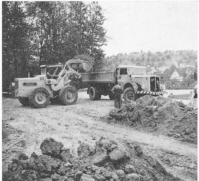
Bild 4. Beladen des Lastwagens mit Pneuladeschaufel
