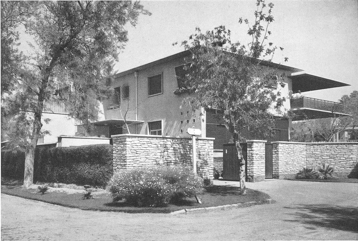
Nordwestecke des Grundstückes mit Einfahrt und Eingang
