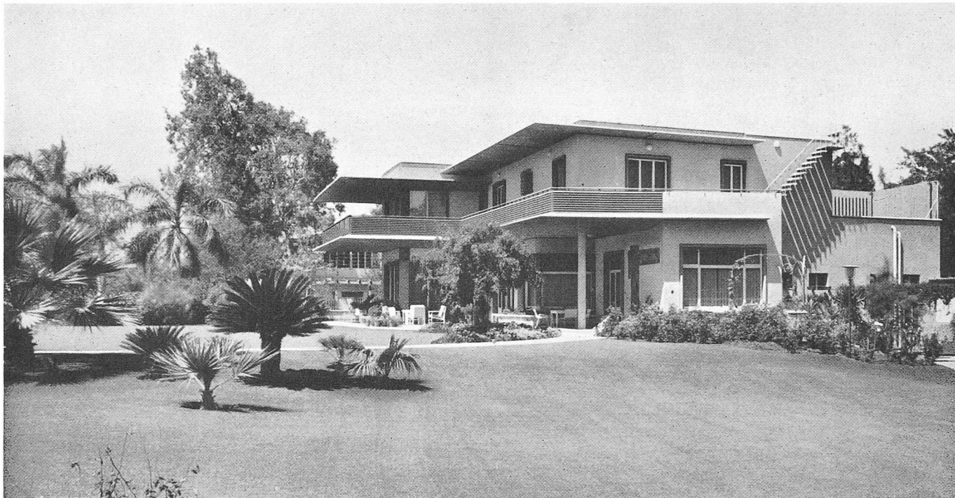
Wohnhaus in Meadi bei Kairo
