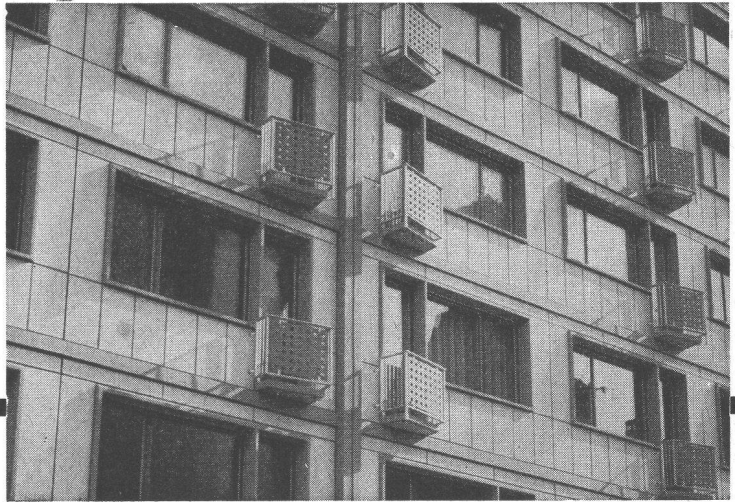
Ausfachung eines Beton-Skelettbau
