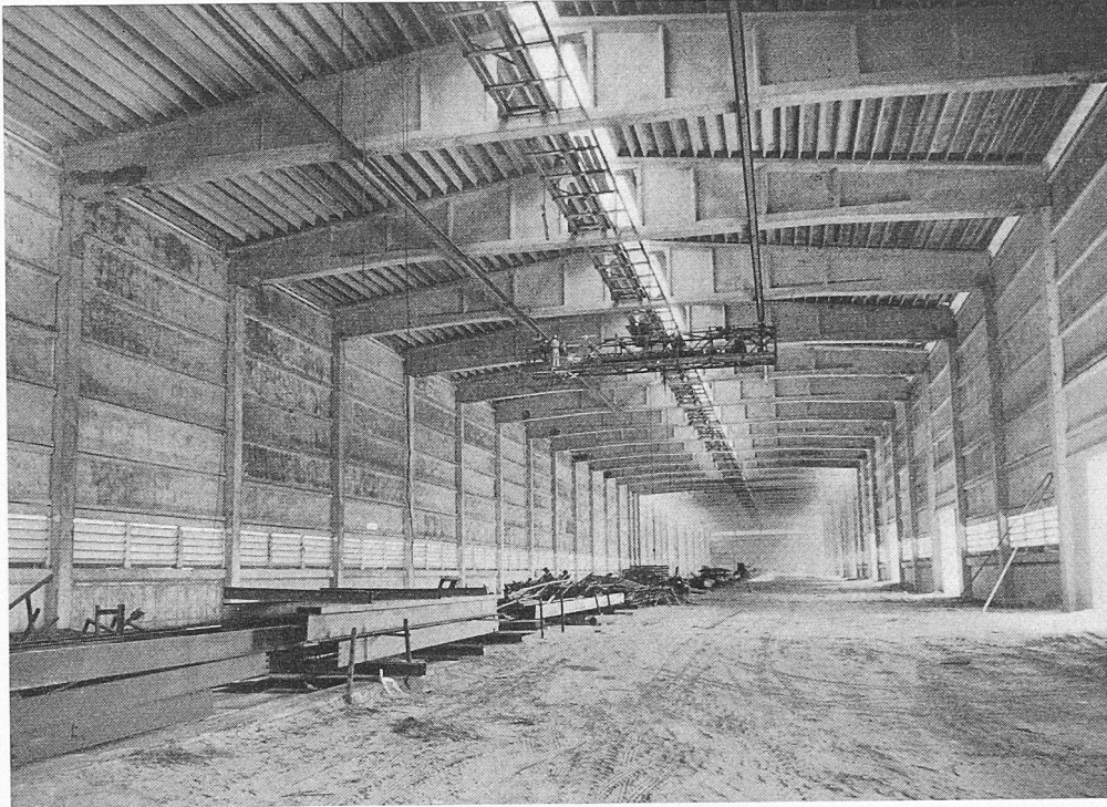
Bild 6. Vollständig vorfabriziertes Industriegebäude. Die sehr verbreiteten T-Träger bilden die Dachelemente. Photo Modern Concrete Magazine, Chicago, Illinois
