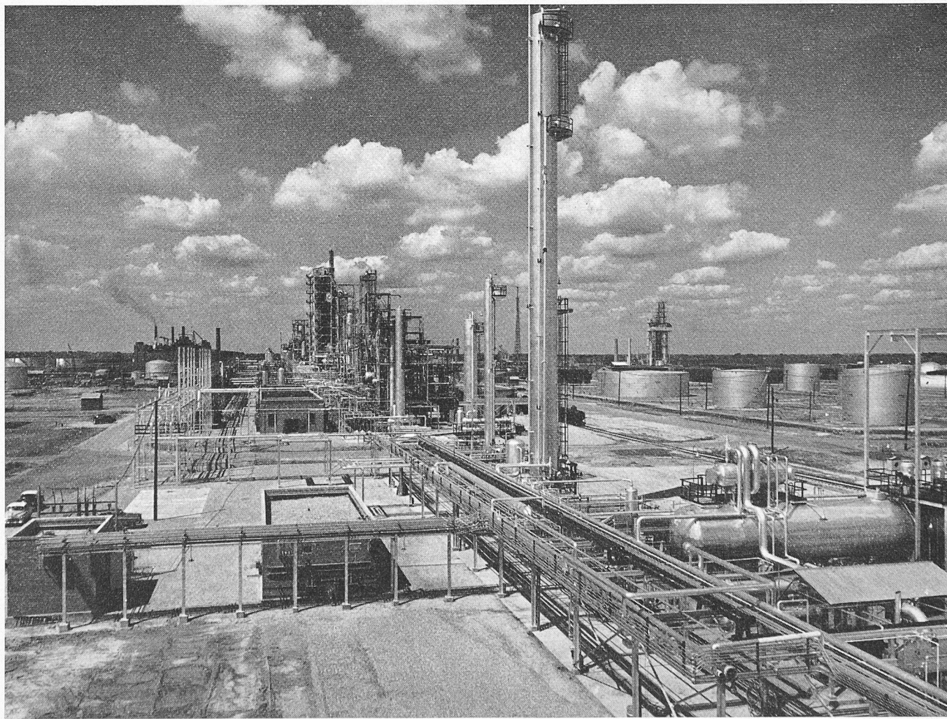
Alkylierungs-Anlage der Ohio Oil Co. in Robinson, Ill., USA, wo leichte Kohlenwasserstoffe (Butylene und Isobutan) zu hochwertigen Isooktanen vereinigt werden, welche vor allem als klopfeste Komponente moderner Flugbenzine Verwendung finden. Im Vordergrund rechts das Reaktionsgefäss (liegender Tank), in welchem die Vereinigung vor sich geht. Dahinter die zur Trennung der leichten Kohlenwasserstoffe dienenden hohen Fraktionierkolonnen. Im Hintergrund weitere Erdölverarbeitungsanlagen
