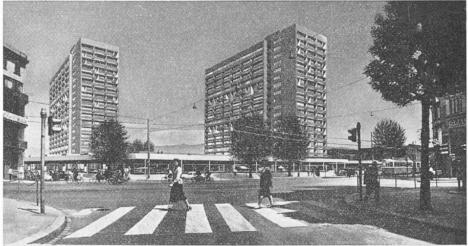
5. Preis; Südwestansicht, im Vordergrund die Badenerstrasse
