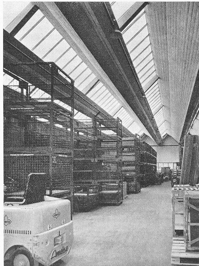
Bild 12. Innenansicht der fertigen Halle
