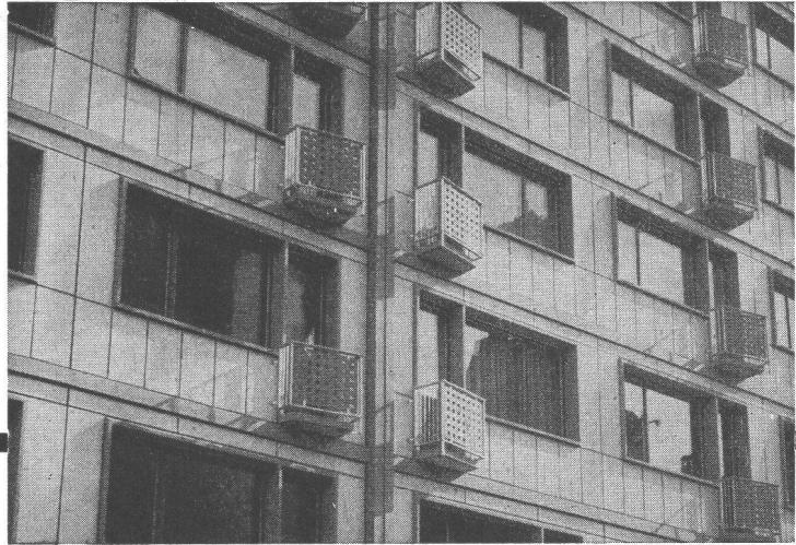
Ausfachung eines Beton-Skelettbau
