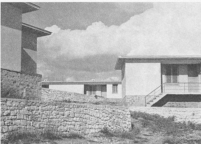
Doppelwohnhäuser für Arbeiter in Agrinion. Arch. Skiadaressis
