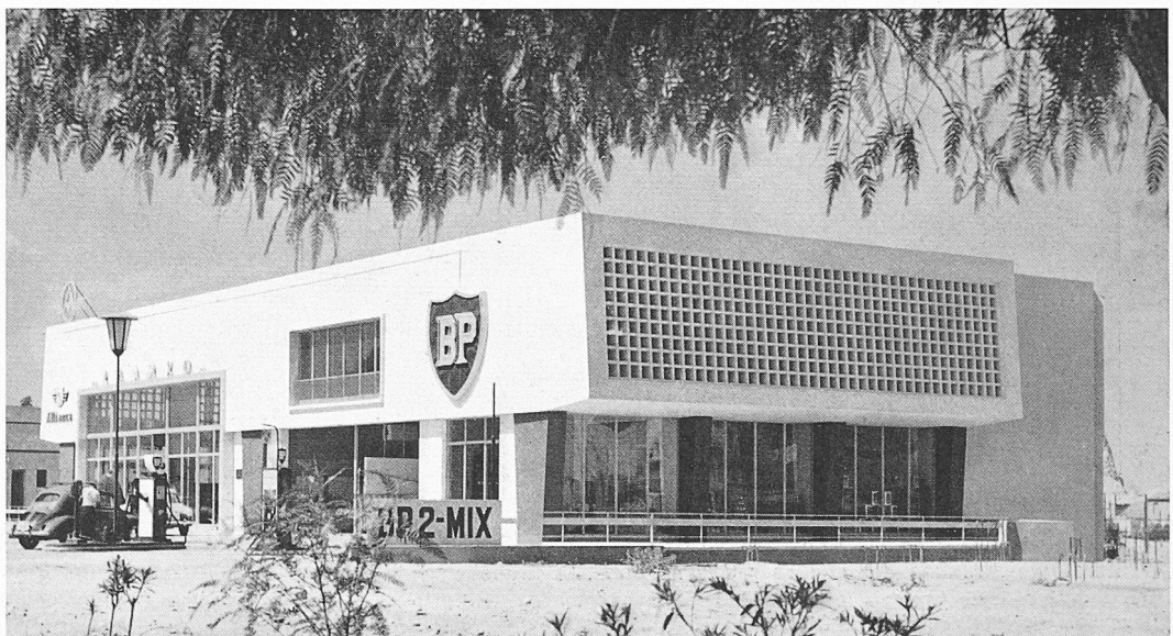
Garage an einer Zufahrtsstrasse nach Athen. Architekt Kapsampelis
