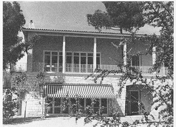
Kindergarten, Vorort von Athen. Arch. Kapsampelis
