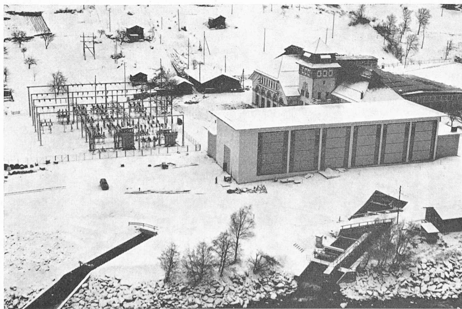
Bild 18. Maschinenhaus Ackersand II im Vordergrund, davor links Unterwasserkanal, rechts Unterwasserkanal des hinten sichtbaren Maschinenhauses Ackersand I (mit Turm und Steildach) Hinten links neue Schaltanlage
