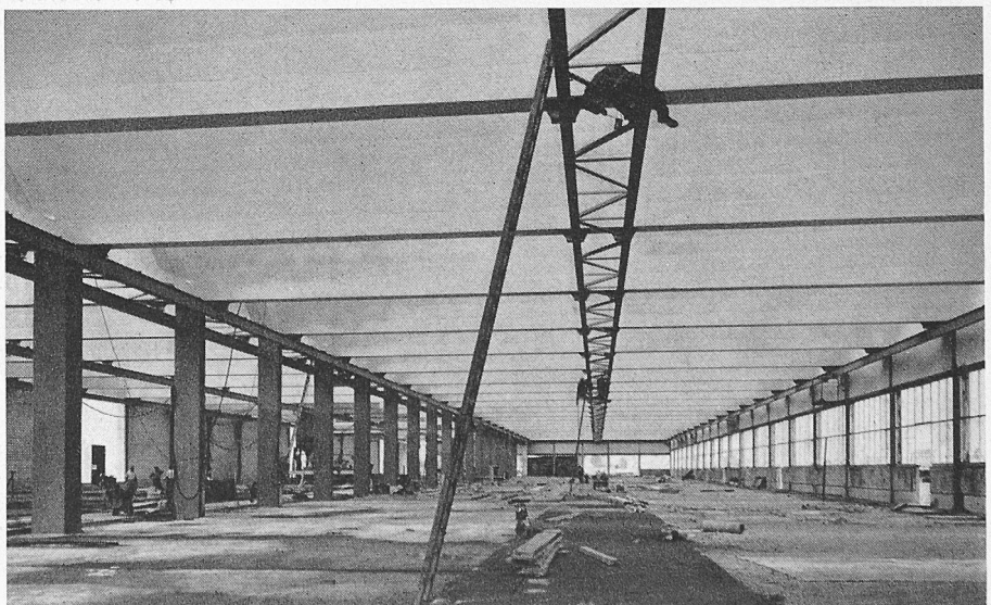
Bilder 6 und 7. Die Weichenbauhalle im Rohbau (Kranbahnmontage)
