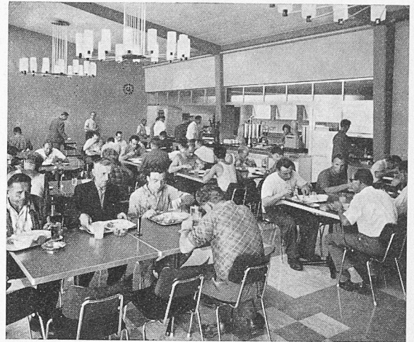
Bild 29. Teilansicht des Speisesaales für 140 Arbeiter, mit Blick in die Küchenanlage
