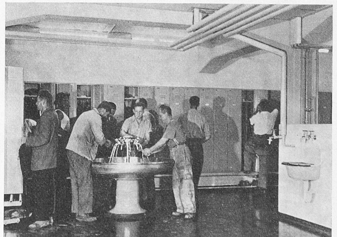
Bilder 30 und 31. Stahlchränke mit feuerverzinkten Sitzbänken und Schuhraster, Waschrinnen und Waschfontänen im Umkleideraum
