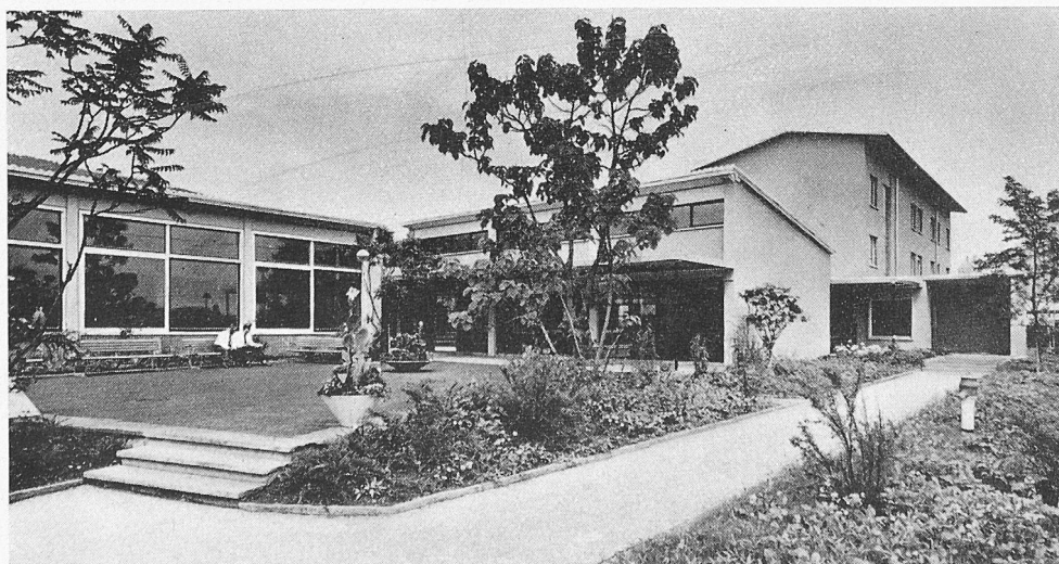
Bild 35. Links Theoriesaal der Bahndienstschule, in der Mitte die Werkkantine mit Leichtmetall-Sonnenschutz, rechts Eingang zum Logierhaus der Bahndienstschule
