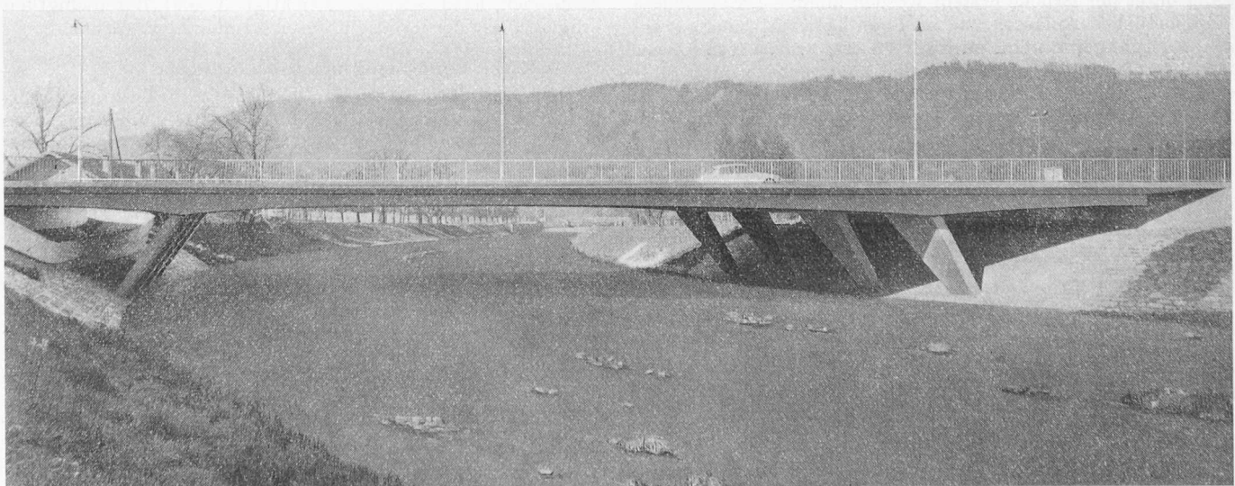
Bild 1. Ansicht der Brücke von der Unterwasserseite
