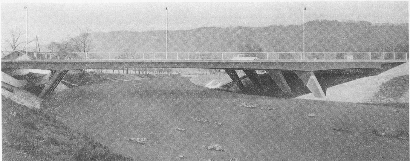
Bild 1. Ansicht der Brücke von der Unterwasserseite
