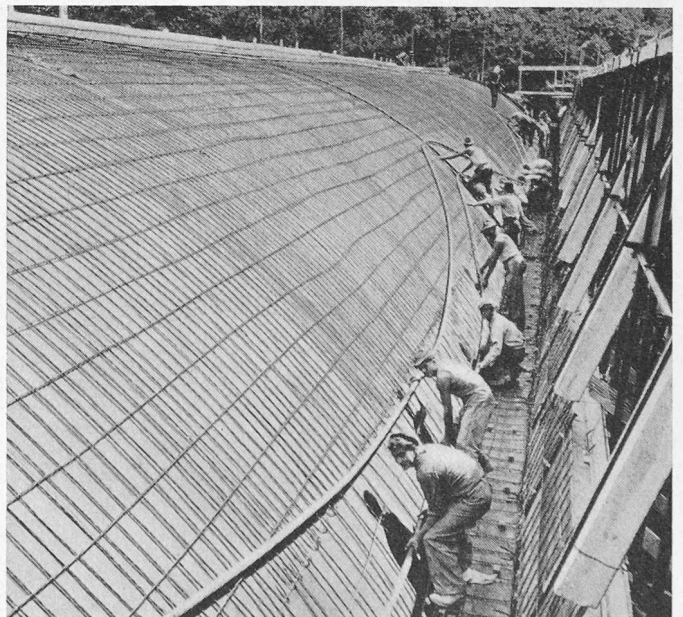
Bild 14. Neubau der Graeter & Cie. AG in Birsfelden, Durchlaufender, vorgespannter Schalenshed
