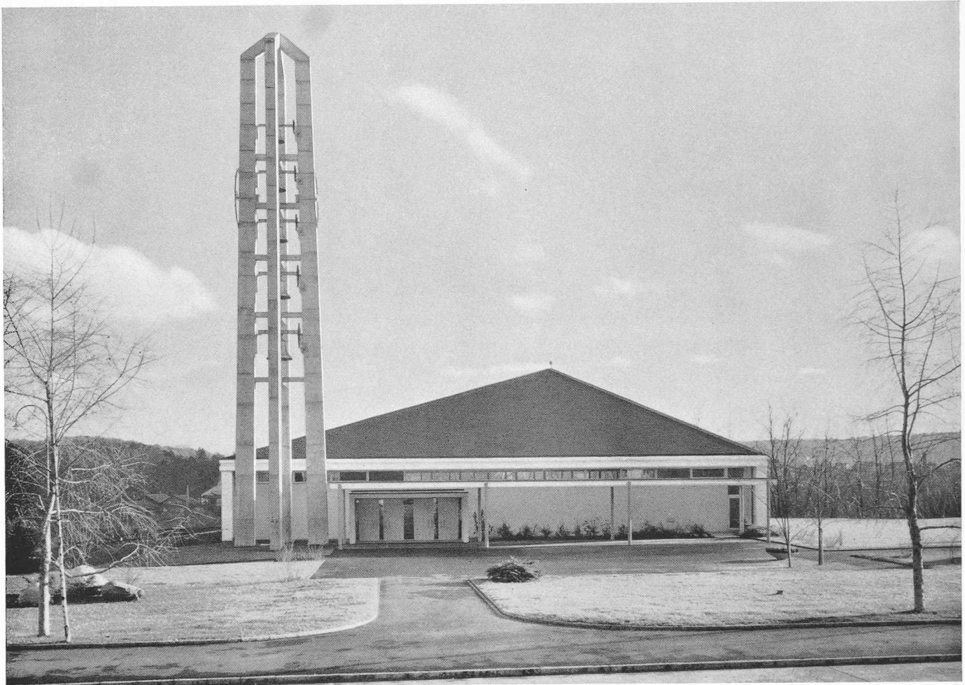
Haupteingang der Zwinglikirche mit Turm. Frei schwebendes Zeltdach, welches auf vier Punkten aufliegt, in Stahlkonstruktion mit Eternitschieferdeckung, mit einer Spannweite von 30 m
