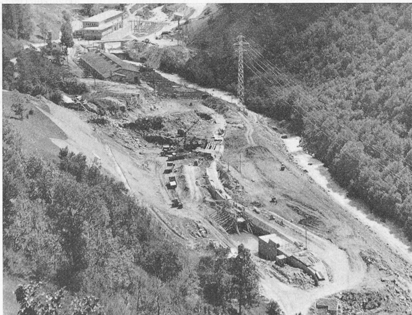
Bild 6. Sommer 1958; Aushubarbeiten, Stollenverstärkung, im Vordergrund Auslauf
