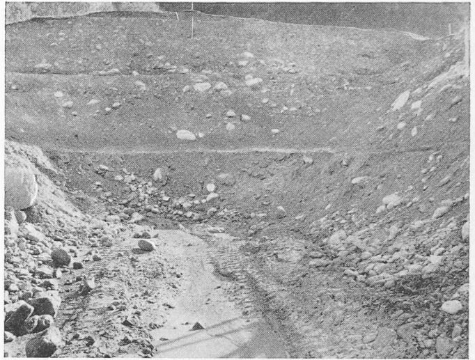
Bild 3. Herbst 1957; grosser, mit Trax ausgeführter Sondierschlitz
