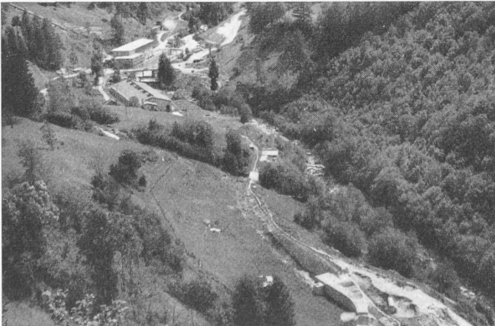
Bild 1. Sommer 1957; das Gelände vor Baubeginn. Neue Zentrale Vissoie, Filtergebäude
