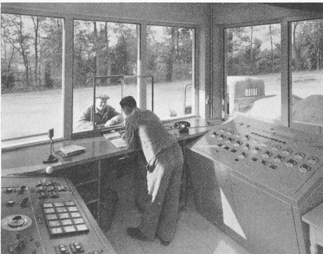
Bild 14. Inneres der Verladestation mit den vollautomatischen Kommandopulten zur Steuerung des Mechanismus, welcher die verlangte Menge genau nach der vorgeschriebenen Kurve zusammensetzt und auf den Lastwagen fördert
