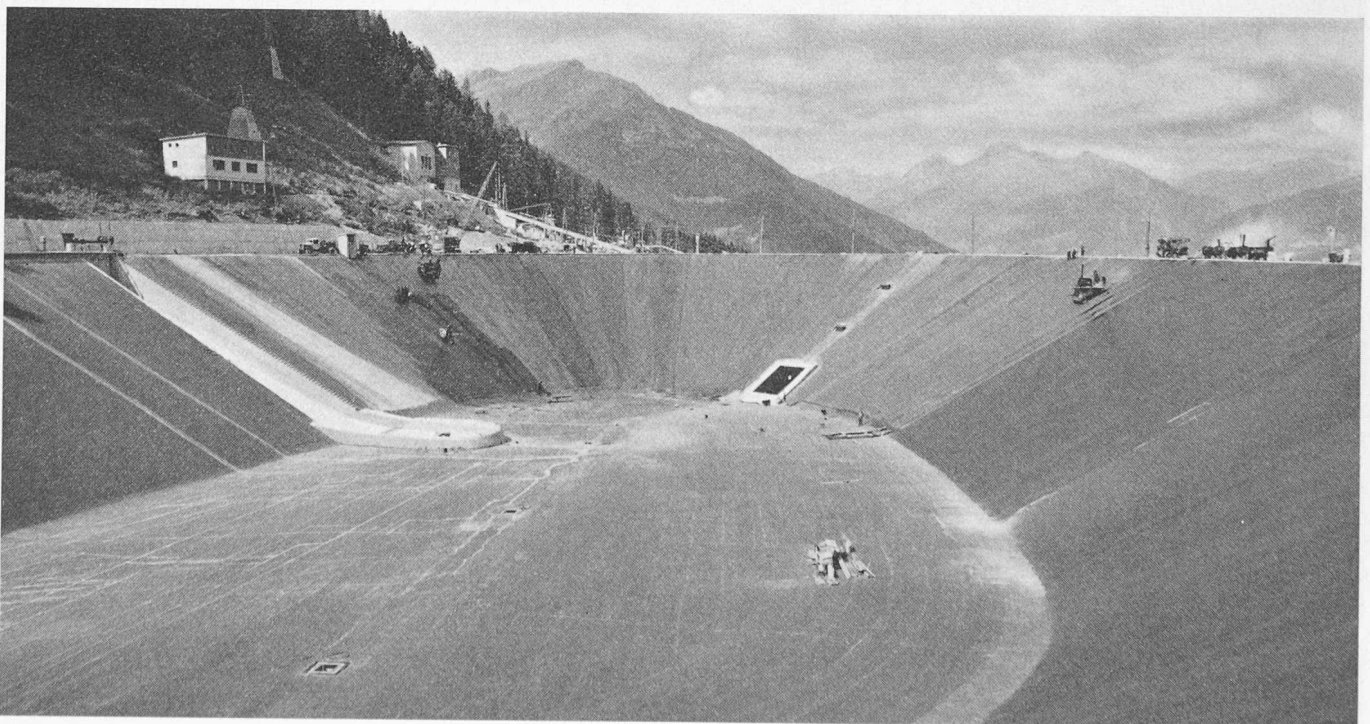
Bild 4. Ausgleichbecken Rosswiese der Oesterreichischen Draukraftwerke
