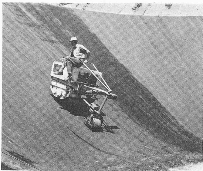
Bild 5. Einbau des Belags beim Ausgleichbecken Vissoie der Kraftwerke Gougrea
