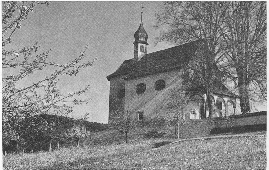
Bild 2. St. Blasius auf Burgrain bei Alberswil von Nordwesten, erbaut 1682
