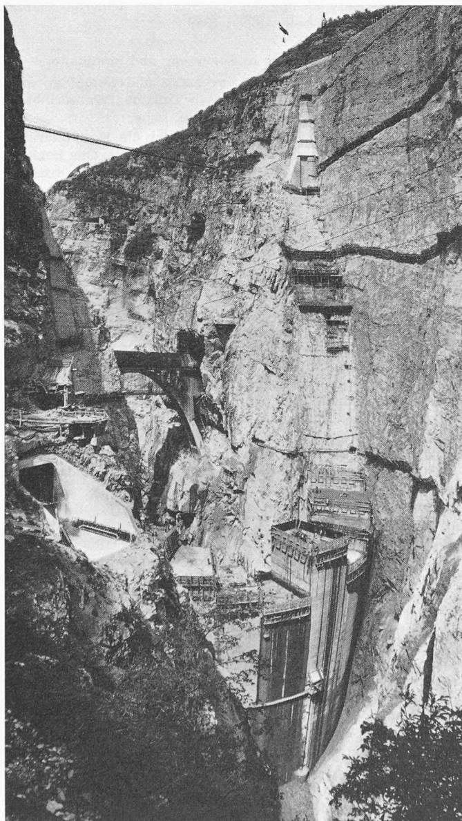
Bild 27. Vaiont-Sperre, Bauzustand am 19. Mai 1959
