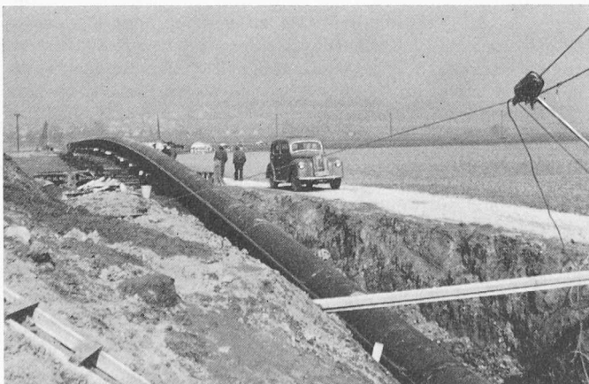
Bild 2. Der Düker zu Beginn des Einziehvorganges
