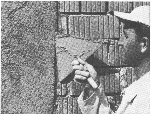
Putzmörtel ohne TRICOSAL-WA lässt sich nur mit Mühe zu einem zufriedenstellenden Putz verarbeiten.
