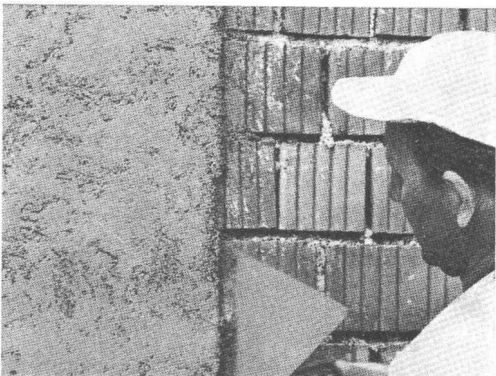
Gleicher Mörtel, nur mit TRICOSAL-WA hergestellt, haftet besser und lässt sich zügig verarbeiten.
