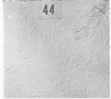
Nr. 44: Schalung Pavatexplatte, mit Paste behandelt. Plafonit haftet sehr gut
