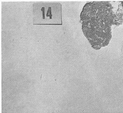
Nr. 14: Schalung ungehobeltes Holz, geölt. Gips mit 2 % Plafonitzusatz haftet nur mässig
