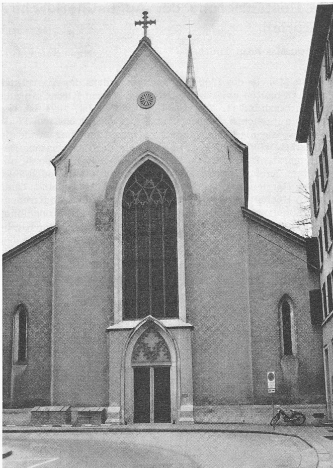
Ostfassade vor der Renovation
