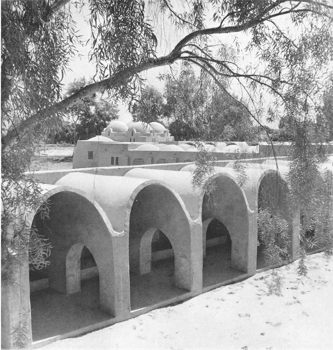
Bild 30. Ausschnitt aus dem Wandelgang, der den quadratischen Platz des Tiermarktes in Gournä umsäumt. An den Nichtmarkttagen dient der ruhige Innenhof den Kindern als Spielplatz. Interessant ist der schräge Abschluss der aus Lehmziegeln freihändig gemauerten Tonnen
