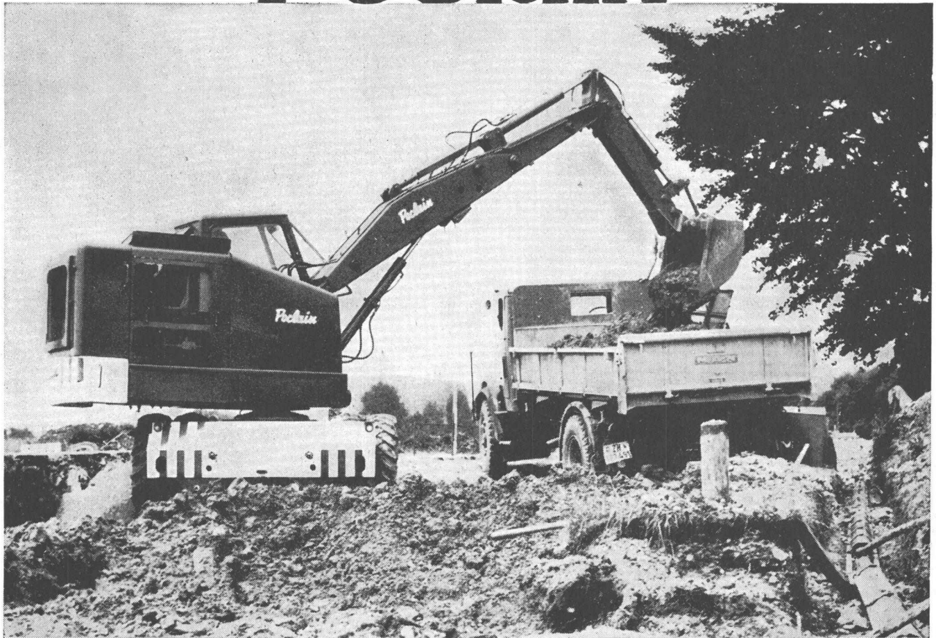
Unser Bild: Verladearbeiten im Strassenkoffer
