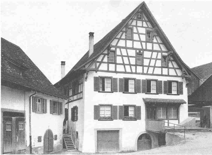
Die Mühle in Bibern, Bezirk Reiat, zeigt im Schluss-Stein des rundbogigen Sandsteintores zum Untergeschoss im Scheitel das Datum 1732. Die Giebelfläche enthält einfaches Riegelwerk. Am Vorsprung des behäbigen Satteldaches Hängekreuze und geschweifte Büge. Im offenen Fenster der Giebelspitze hängt eine Glocke ohne Inschrift, 18. Jahrhundert. Das Innere ist vollständig modernisiert.
