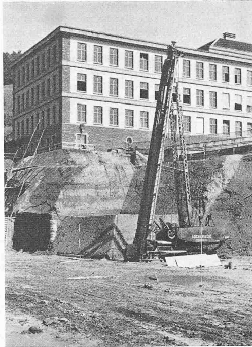
Bild 7. Ramme auf der Baustelle Kantonsschule Winterthur (Photo E. Järman)
