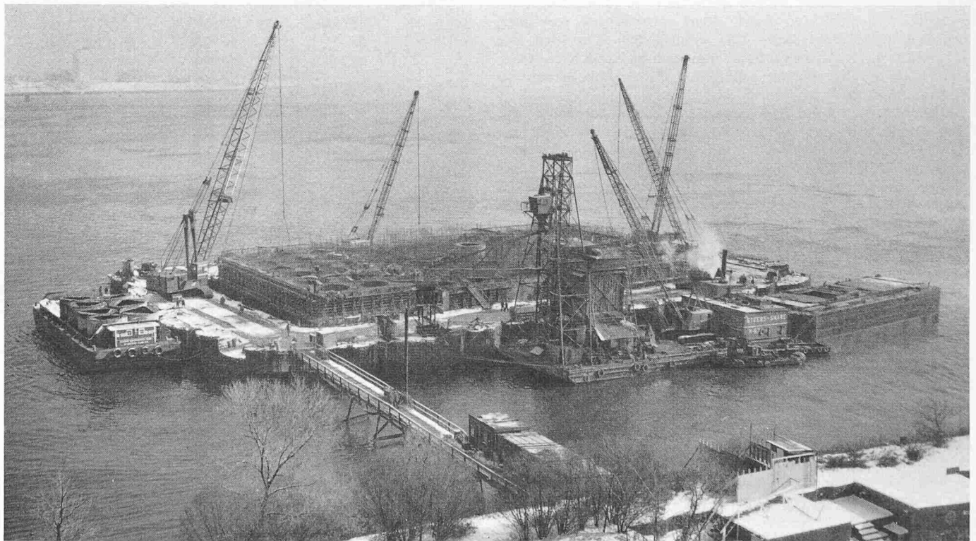
Bild 6. Fundament des Pylons Seite Staten Island, Blick gegen Südosten am 30. Dez. 1960. Plazieren der Schalungen für die elfte Betonieretappe
