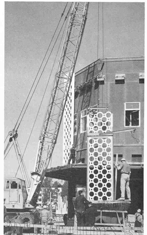
Bild 19. Verkleidung eines Warenhauses
