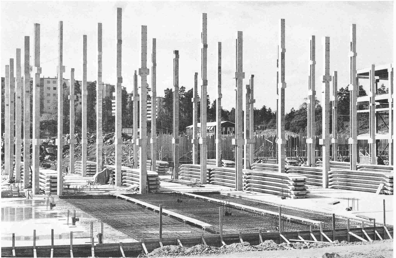
Bild 17. Vorfabrizierte Elementbauweise: Ständer aus Eisenbeton
