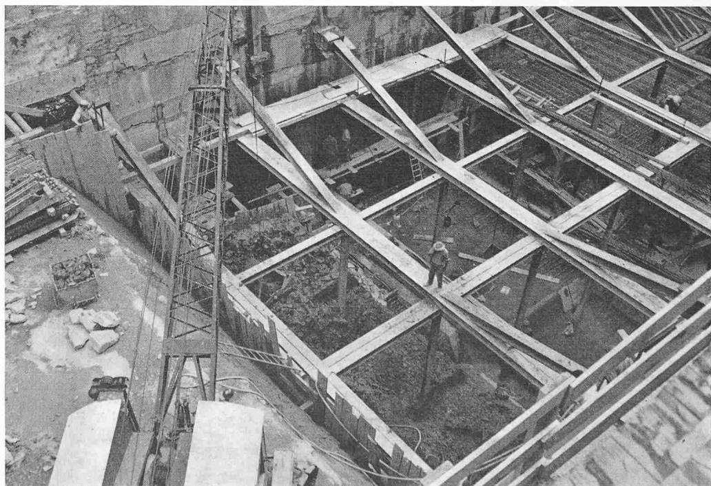
Fig. 15. Terrassement de la fouille par tranches d'environ 4,20 m de longueur. Etaisage métallique de la fouille. Travaux de bétonnage des radiers des parois et des murs
