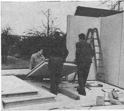
Ein Bauelement von Stockwerkshöhe kann von drei Männern getragen werden
