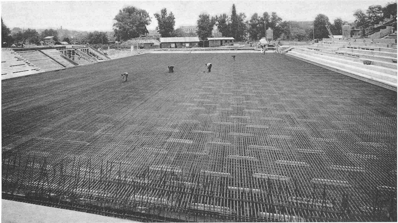
Bild 14. Kunsteisbahn Genf. Ansicht der Piste nach Verlegen der Kühlröhren, vor dem Betonieren der Platte
