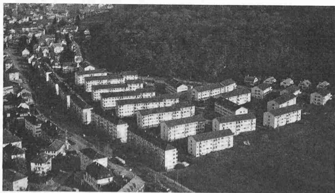
Wald und Besiedelung. Der Wald bietet der Ausdehnung der Besiedelung Halt. Leider enthalten viele Gemeinde-Bauordnungen keine grösseren Bauabstände von Wohnbauten zum Wald. Eine zu enge Kontaktzone zwischen Wohnbauten und Wald ist für beide ungünstig. Photo Swissair
