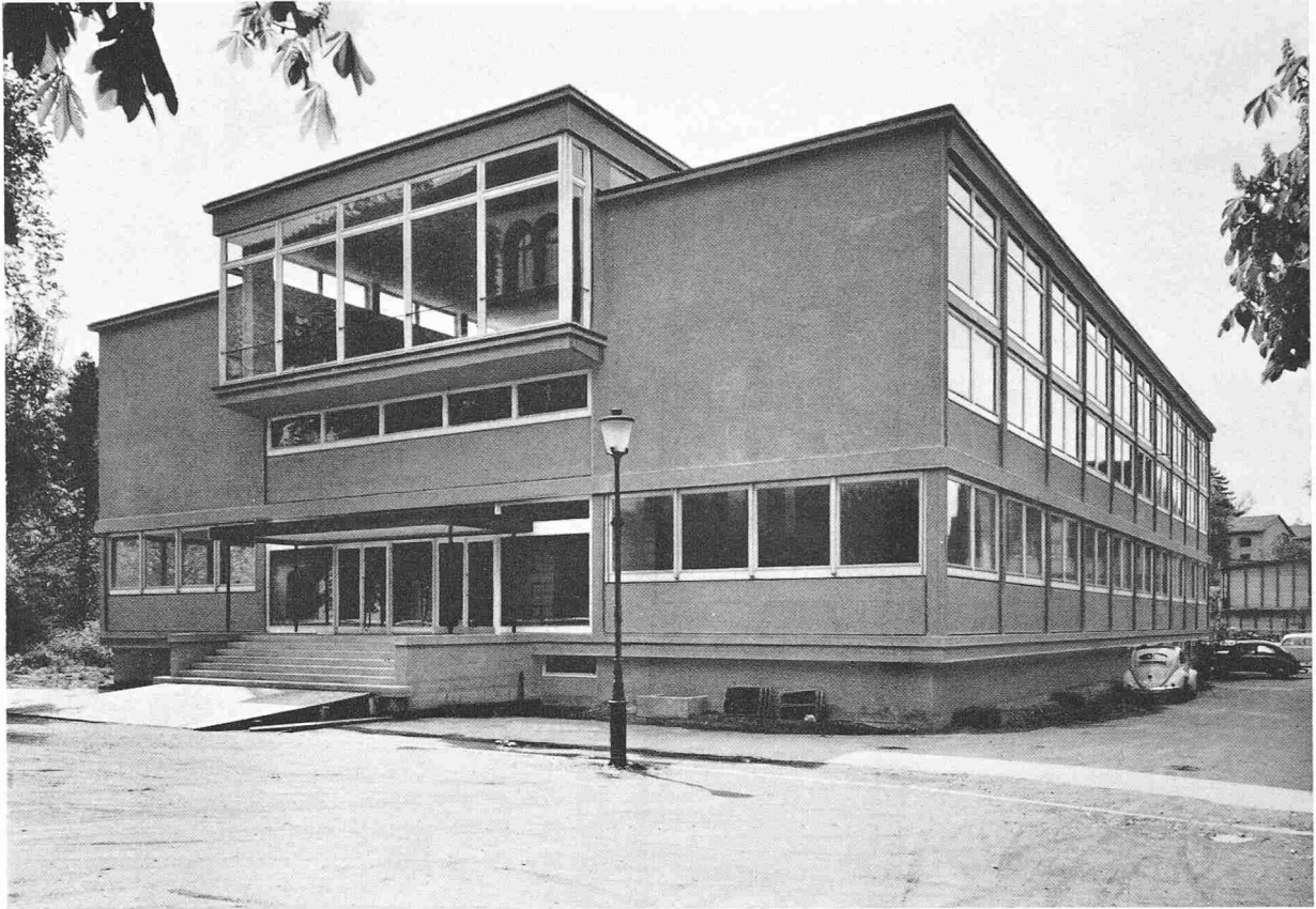
Neues Physikgebäude des Technikums, von Nordosten. Im Galeriegeschoss ist die Pausenhalle horizontal und vertikal (zwecks seitlicher Belichtung) vorgezogen, ein Motiv, das sich beim grossen Hörsaal wiederholt. Die Aussenfassaden bestehen durchgehend aus Eisenbeton. Die Flächen sind mit Zahneisen so bearbeitet, dass die Nagelfluhstruktur des Betons zum Ausdruck kommt
