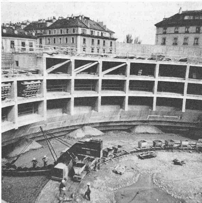
Bild 13. Aushub mit Eimerkettenbagger
