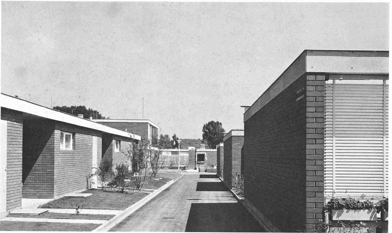
Blick von der Niederbergstrasse gegen Norden auf den Platz
