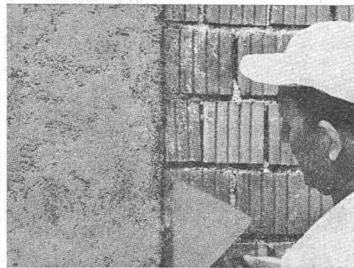
Gleicher Mörtel, nur mit TRICOSAL-WA hergestellt, haftet besser und lässt sich zügig verarbeiten.
