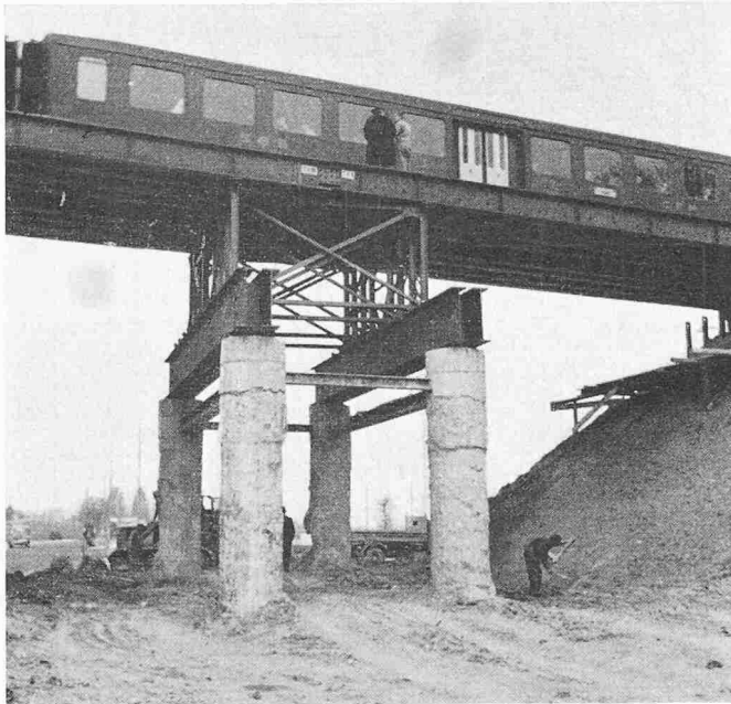
Bild 5. Teilweise ausgegrabene Icos-Veder-Pfähle bei der Belastungsprobe
