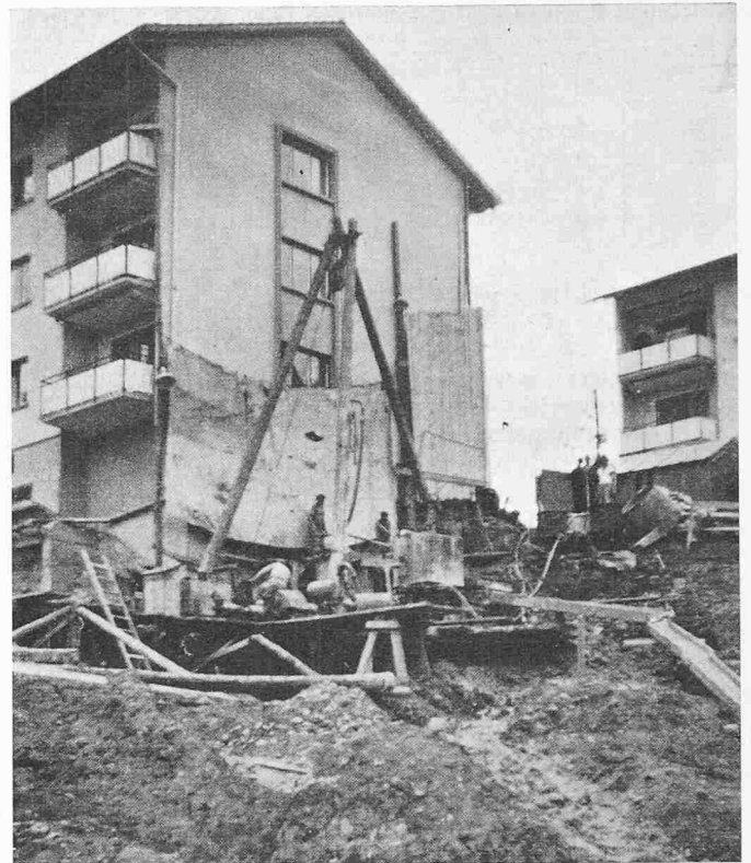
Bild 7. Gebäudeunterfangung an einem Steilhang
