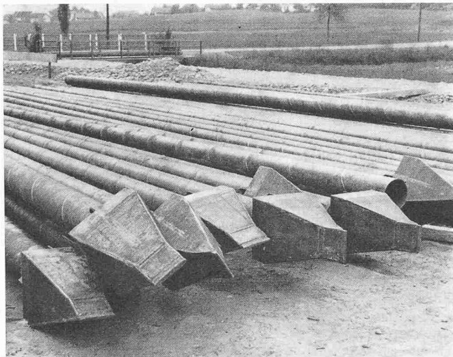
Bild 1. Stapel zur Rammung bereitliegender MV-Pfähle
