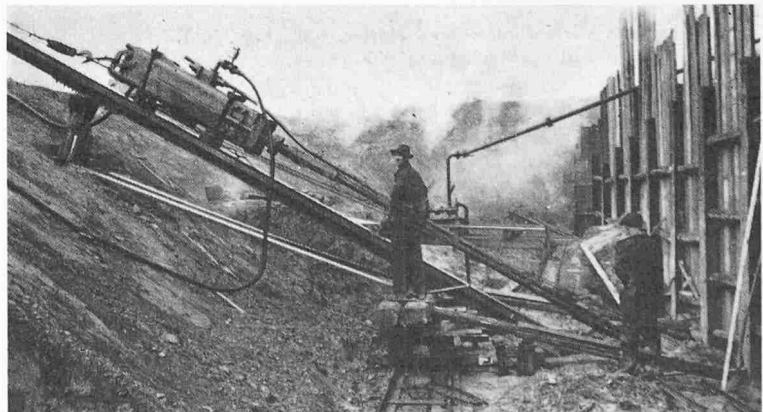
Bild 8. Rammung eines Pfahles mit Neigung 1:2, zur rückwärtigen Verankerung einer Stützmauer
