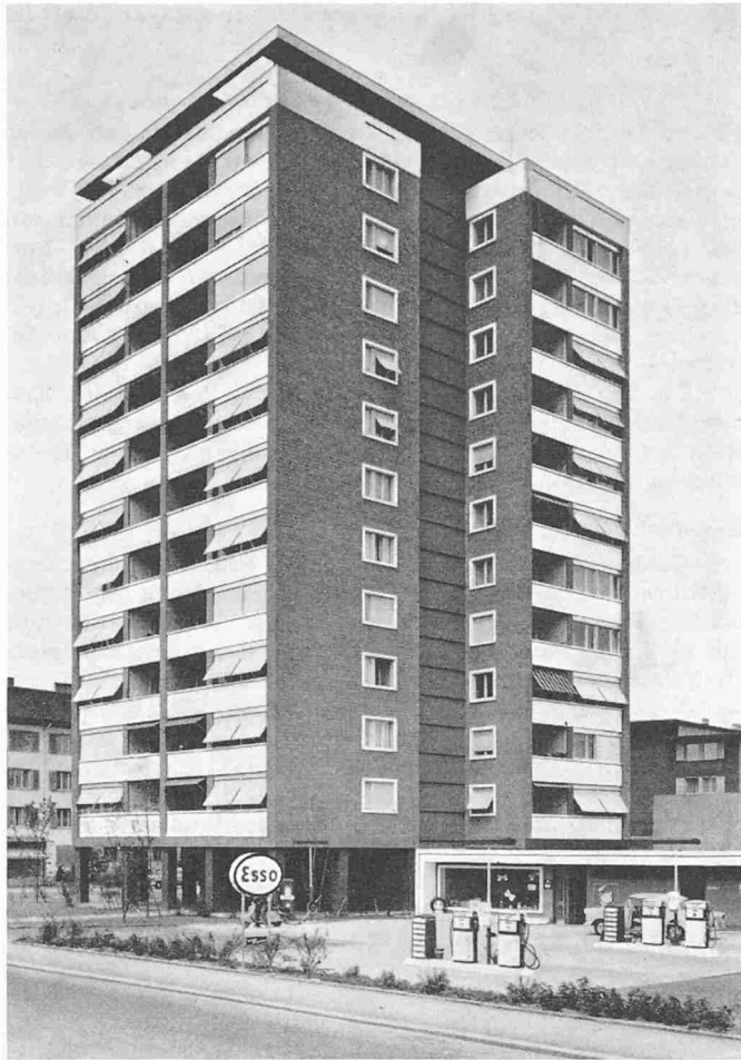
Ansicht von Südosten
