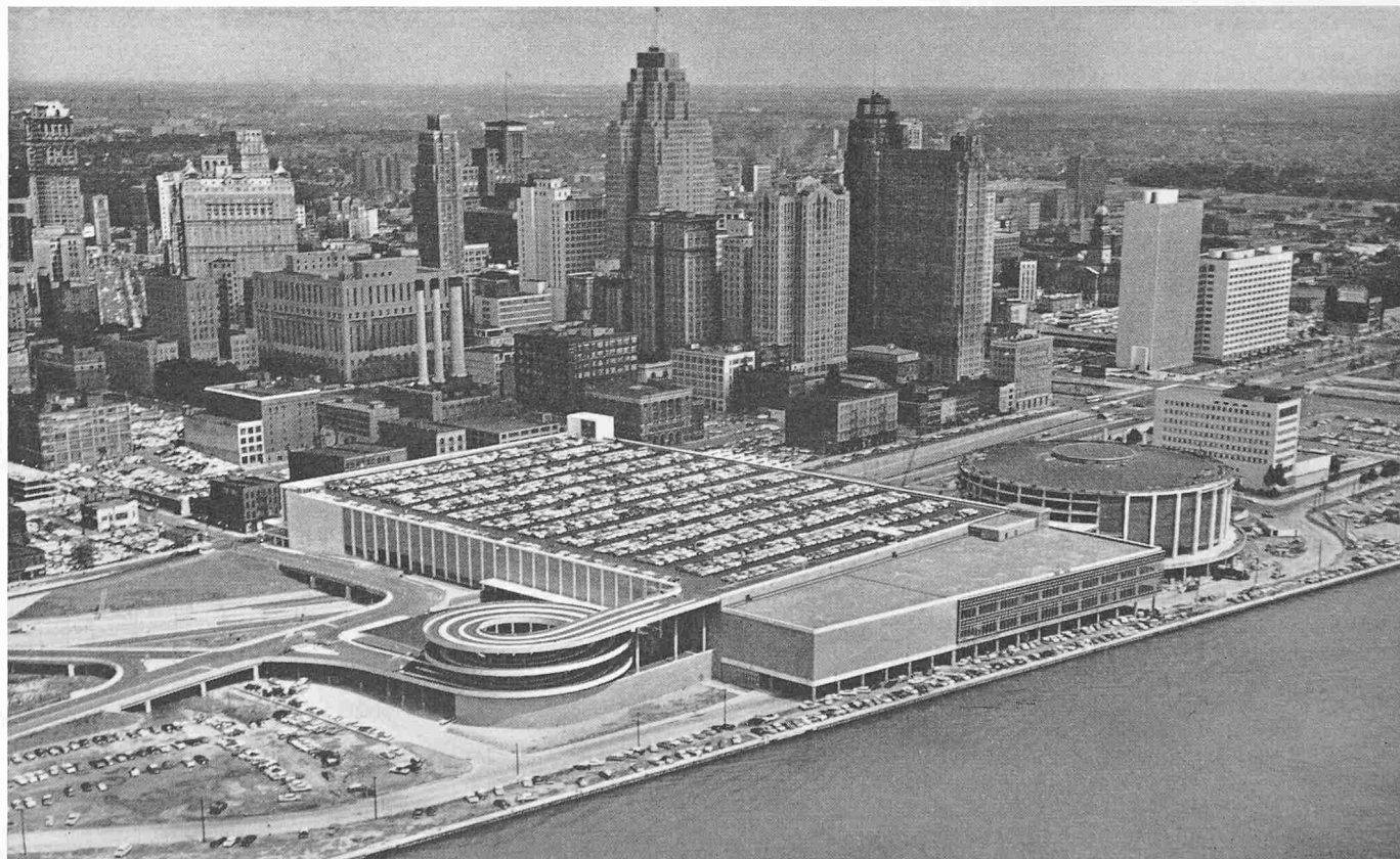
Bild 1. Cobo Hall in Detroit. Im Vordergrund die spiralförmige Auffahrtsrampe zur Dachparkierung (1150 Wagen), rechts das Arena-Gebäude, darüber (im Hintergrund) das City-County-Verwaltungs-Gebäude (vgl. Bild 2, S. 632)
