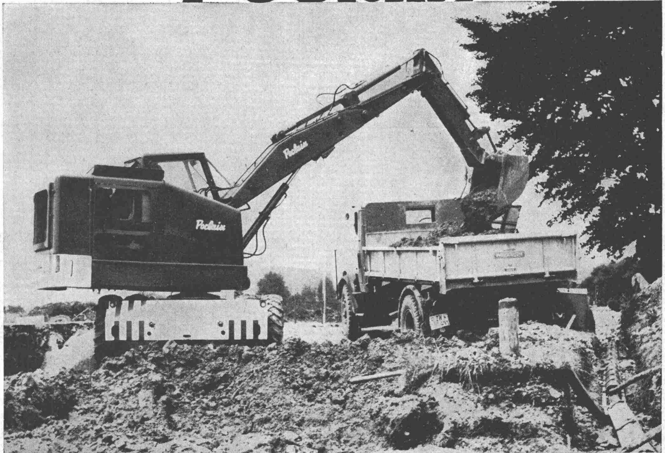
Unser Bild: Verladearbeiten im Strassenkoffer
