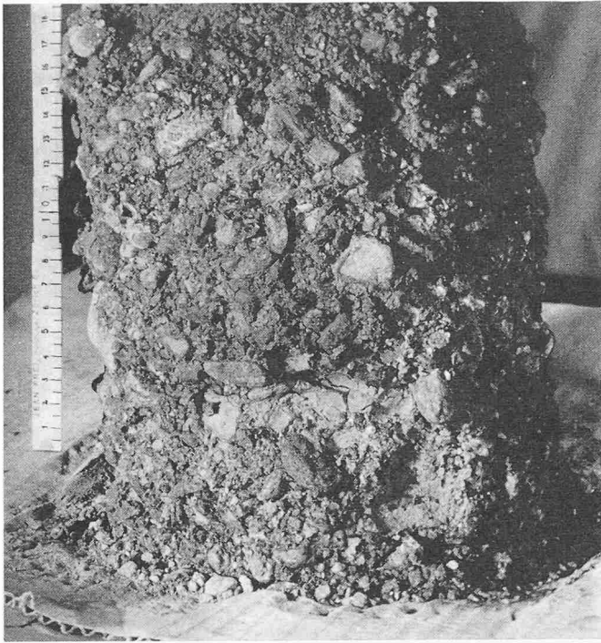
Bild 18. Injektionsprobe aus Mattmarkmaterial, das mit gefärbtem Injektionsgut behandelt wurde
