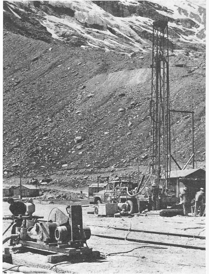
Bild 22. Bohrgerät Rotary Keystone-Frank mit Pumpe
