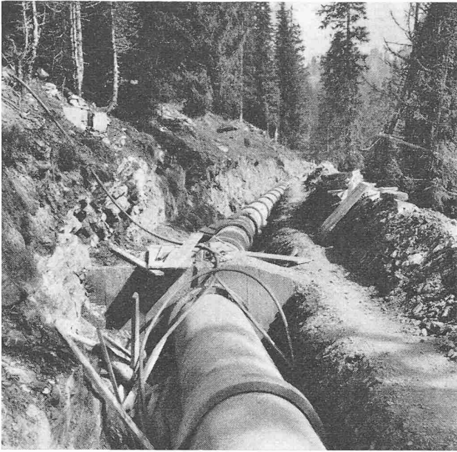
Bild 5. Hangleitung zwischen Hengli- und Engstlenbachfassung
