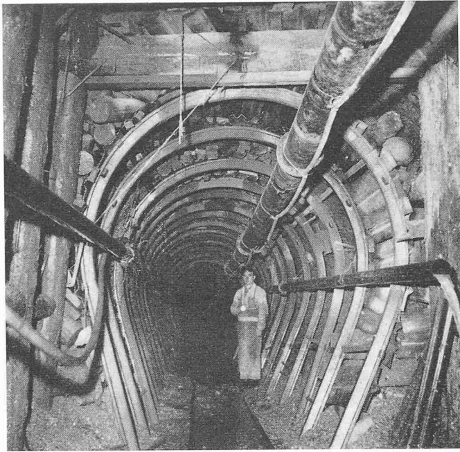
Bild 8. Druckstollen zwischen Teufilai und Wasserschloss Birch-lai, Bauzustand 8. Nov. 1958
