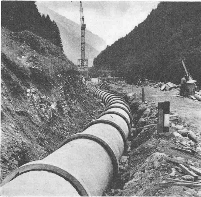
Bild 11. Pumpwasser-Zuleitung zur Zentrale Führen, Bauzustand 17. Aug. 1959
