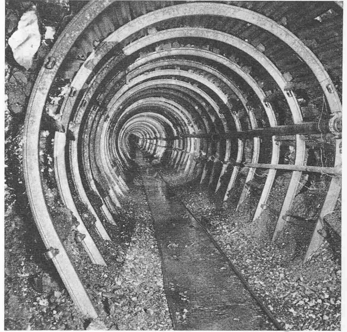
Bild 6. Stollen zwischen Engstlenbachfassung und Ausgleichbecken Teufлаui, Bauzustand 1. Okt. 1959
