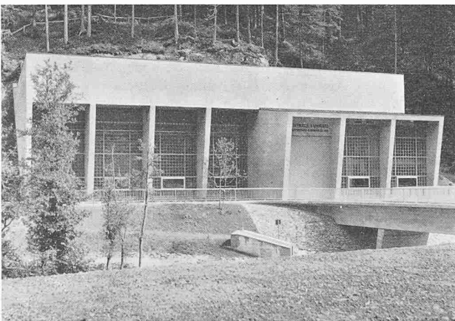
Bild 14. Ansicht der Zentrale Fuhren
